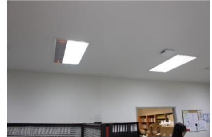
รูปที่ 2.12 หลอดไฟภายในอาคารขาดการดูแลบำรุงรักษา บางส่วนชำรุดและเสื่อมสภาพแต่ยังไม่มี เปลี่ยนหลอดไฟให้สามารถกลับมาใช้งานได้ตามปกติ (ซ้ายและขวา)
