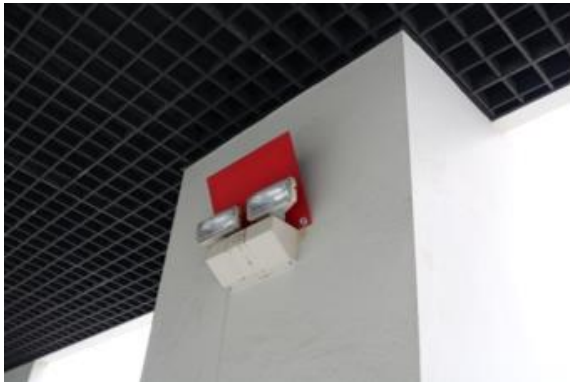
รูปที่ 2.38 ชุดไฟฟ้าแสงสว่างฉุกเฉินหลายส่วนมีปัญหาเรื่องการดูแลบำรุงรักษาให้อยู่ในสภาพที่เหมาะสมกับการใช้งาน บางส่วนมีปัญหาเรื่องความสะอาดของอุปกรณ์ (ซ้ายและขวา)
