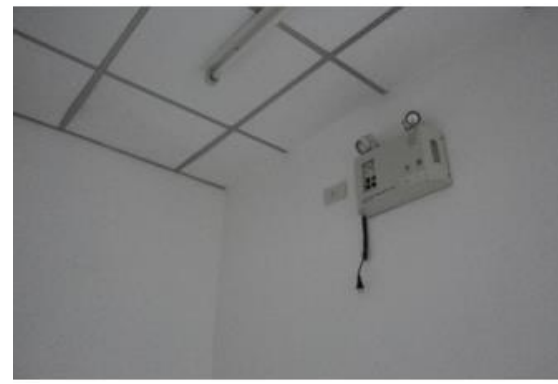
รูปที่ 2.42 ระบบไฟฟ้าแสงสว่างฉุกเฉินในอาคารหลายแห่งไม่ได้ต่อสายไฟเข้ากับแหล่งจ่ายกระแสไฟฟ้า ทำให้ไม่สามารถใช้งานได้ (ซ้ายและขวา)
