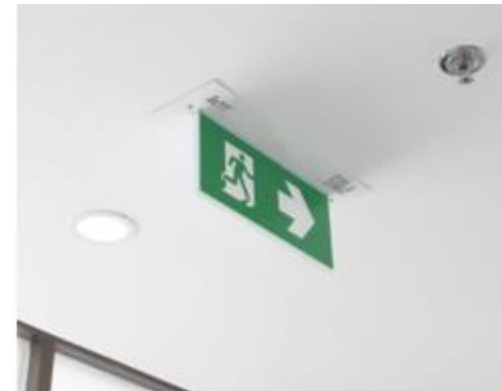
รูปที่ 2.36 เครื่องหมายและไฟป้ายบอกทางออกฉุกเฉินภายในอาคาร (ซ้ายและกลาง) และพื้นที่ติดภายนอกอาคาร (ขวา) หลายส่วนไม่สามารถใช้งานได้ตามปกติ เนื่องจากไม่มีแสงสว่างส่องออกมาจากตัวป้าย
