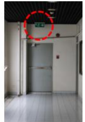
รูปที่ 2.36 เครื่องหมายและไฟป้ายบอกทางออกฉุกเฉินภายในอาคาร (ซ้ายและกลาง) และพื้นที่ติดภายนอกอาคาร (ขวา) หลายส่วนไม่สามารถใช้งานได้ตามปกติ เนื่องจากไม่มีแสงสว่างส่องออกมาจากตัวป้าย
